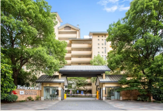
東和苑エントランス & 千禧大酒店敷地内レジデンス棟
